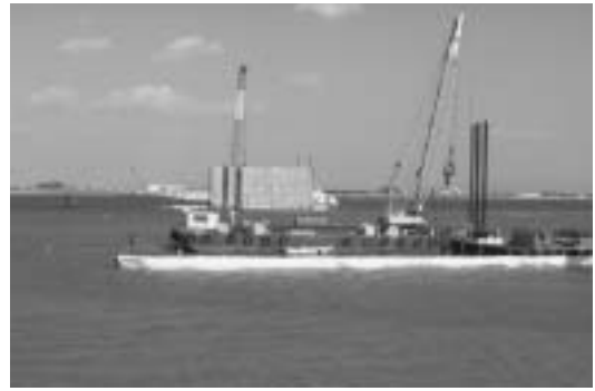
建設中の東環状大橋
