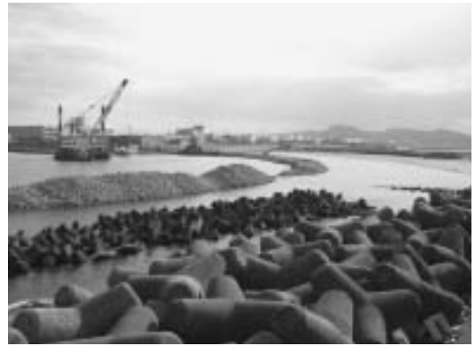
マリンピア沖洲埋立工事
