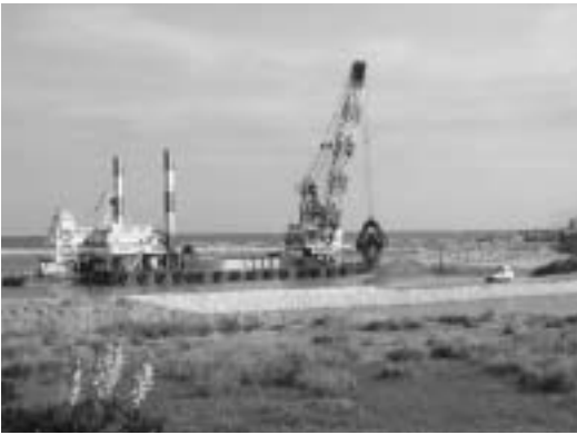
マリンピア沖洲埋立工事
