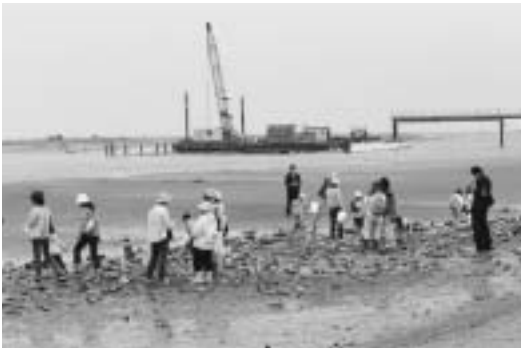
干潟観察会と東環状大橋建設
