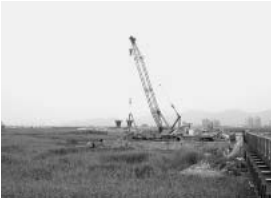
鳴旨大橋架橋工事
