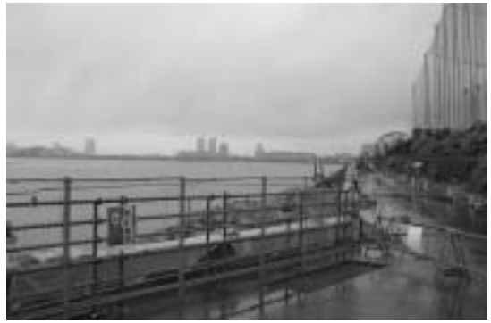
工事が始まった塩浜2丁目の石積み傾斜護岸
