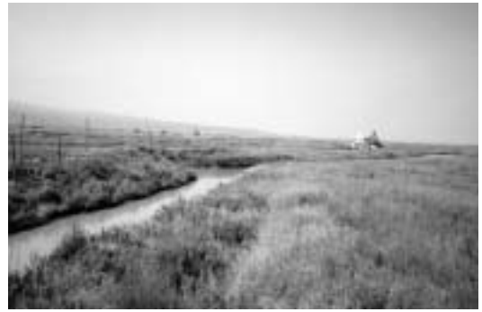
干拓工事現場
