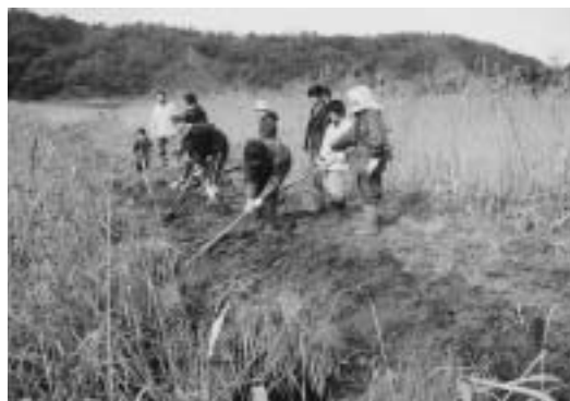
江掘りと呼ばれる小川の水利整備作業
